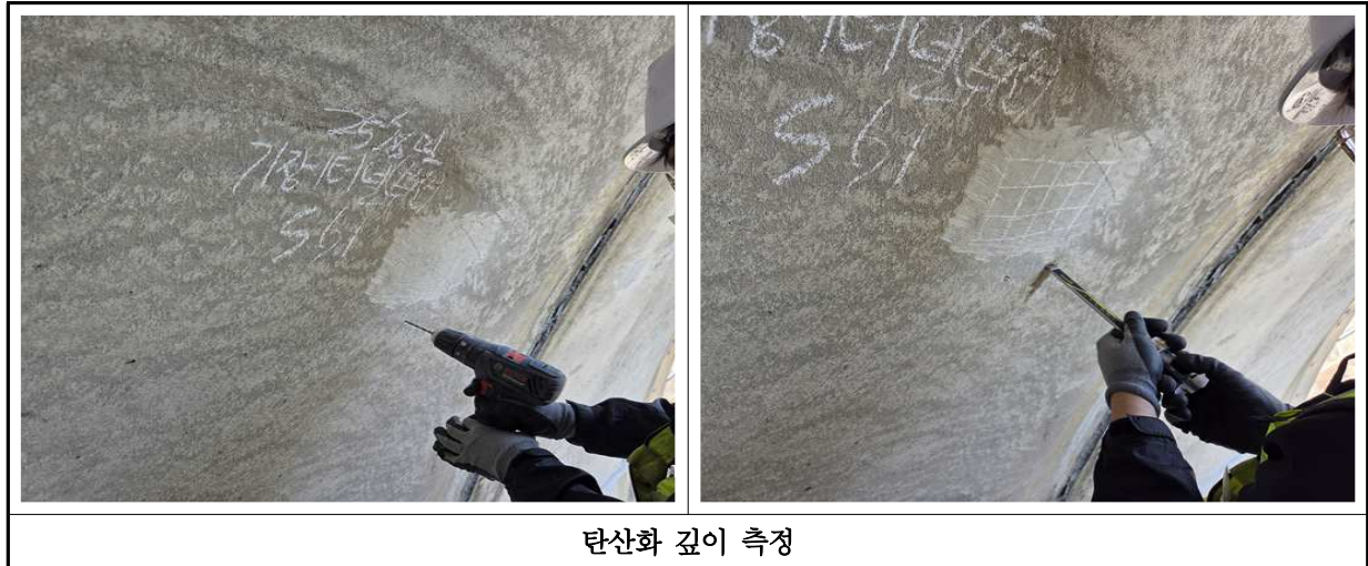
【사진 1.4.2】 탄산화 깊이 시험 현장사진
